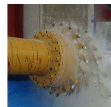
図-8 切削機械の試験施工
