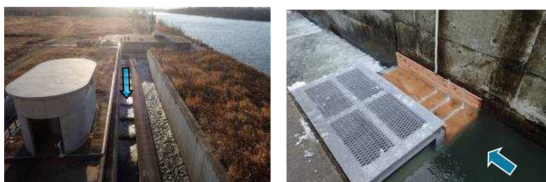
写真-1 十勝川千代田新水路の魚道に設置したシロサケ用魚カウンター
