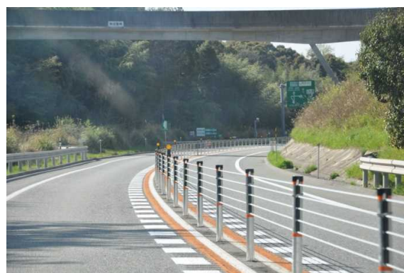
写真-1 設置状況【浜田自動車道】 (島根県浜田市)
