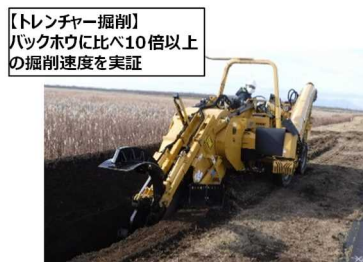
図-2 トレンチャーによる掘削迅速化を実証
