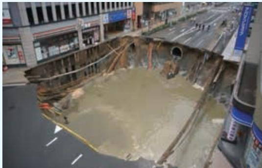
写真-1 道路陥没状況（福岡市交通局ホームページより引用）
