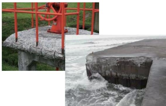
写真-1 凍害や塩害・摩耗との複合劣化（樋門・沿岸構造物）
