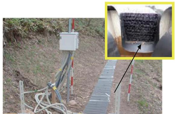
写真-4 新技術による小段排水工試験施工
