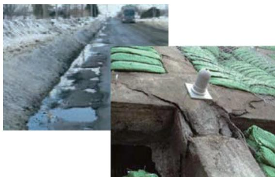
写真-2 凍上や融雪水による損傷（道路舗装・コンクリート法枠）
