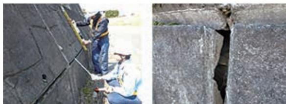
図-5 熊本地震における大型ブロック積み擁壁の被害調査と分析状況
