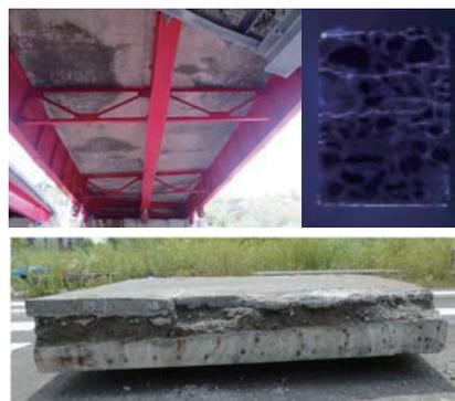
写真-3 橋梁床版の劣化状況
