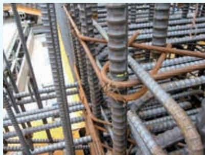
写真-1 部材接合部の密な配筋状況
