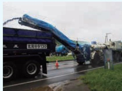
写真-1 舗装切削工事
