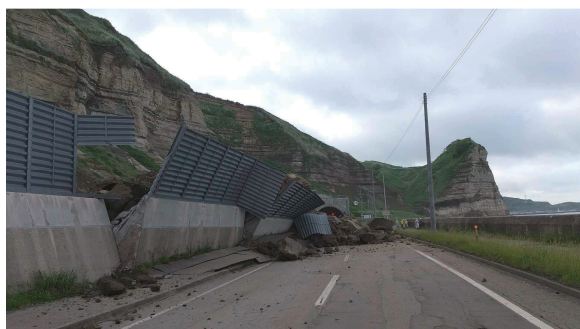
写真 - 1.1.3.3 国道229号の現地状況
