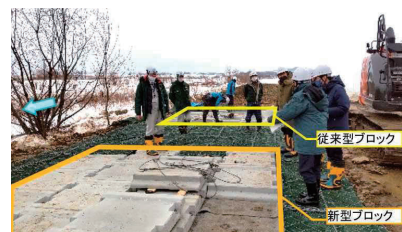
図-8 新型ブロックの現地における試験施工の様子
