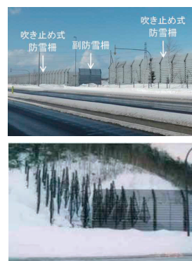
図-5 防雪柵の端部と開口部の対策例
