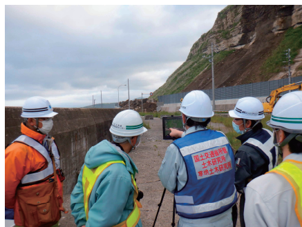
写真 - 1.1.3.4 道路管理者との打合状況
