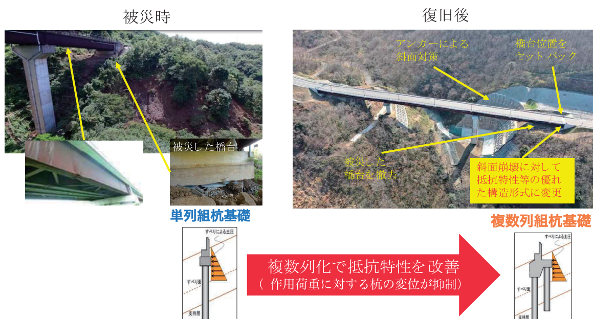
図-1 被災橋梁の復旧に研究成果が活用された例
