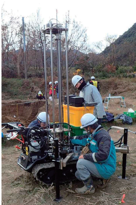
写真-1 自走式静的貫入試験装置
