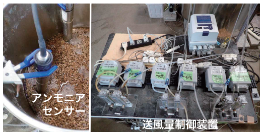
写真-2 アンモニアセンサーによる送風量制御装置
