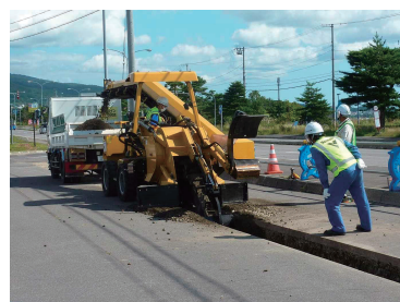
写真-2 トレンチャー掘削状況
