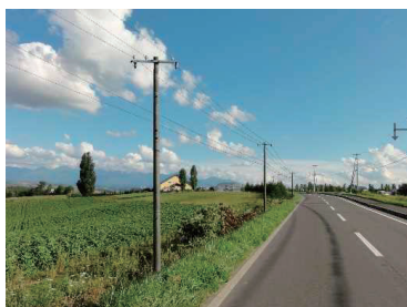
写真-1 電線類地中化ニーズの高い郊外部の道路
