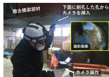
写真-1 ビデオスコープによるケーブル定着部の調査
