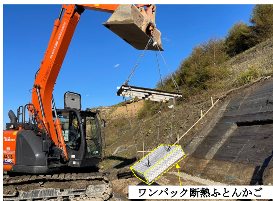
写真-1 ワンパック断熱ふとんかごの施工状況
