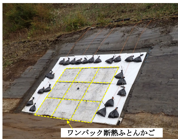
写真-2 ワンパック断熱ふとんかごの設置状況
