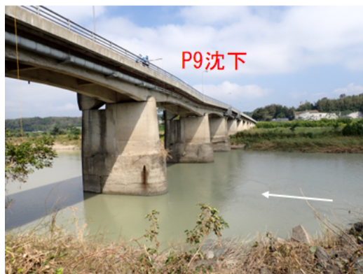
図-1 橋脚・桁沈下被災事例(球磨大橋 昭和32年竣工・ケーソン基礎 令和5年発生)
