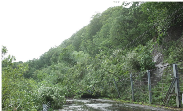
写真 - 1.2.1.3 国道277号の現地状況
