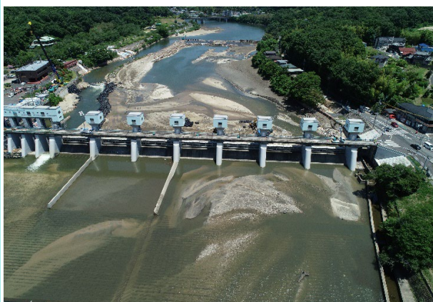
写真-1 明治頭首工漏水事故 堰上流水位低下 (中部地方整備局提供)
