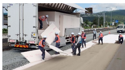
写真-1 断熱材の施工状況
