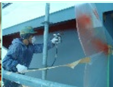
写真-2 橋梁を模擬した実大試験体を用いた現場施工性の検証
