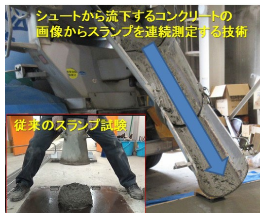
写真-3 画像解析によるスランプの連続測定技術のイメージ
