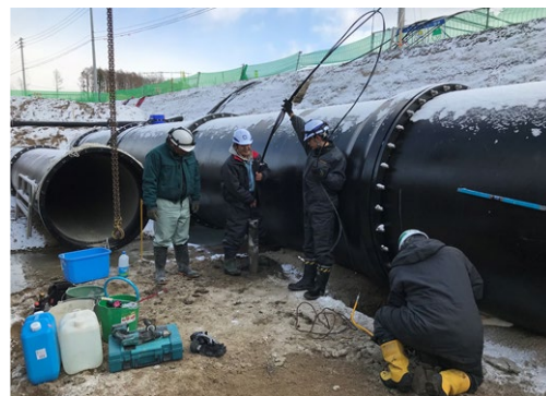
写真-2 管水路への沈下計の設置状況
