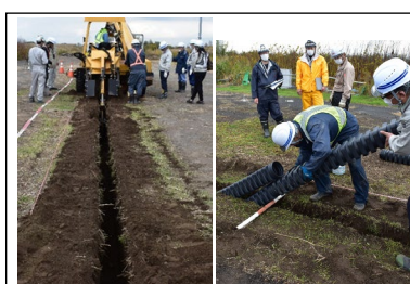
▲細い掘削断面内への管路敷設の試験を行い、十分な作業性を確認
