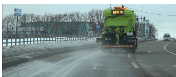
図-1 凍結防止剤散布支援システムの散布状況
