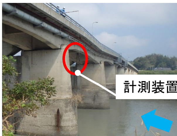
写真-2 現地計測の様子
