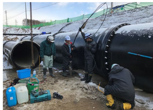
写真-2 管水路への沈下計の設置状況
