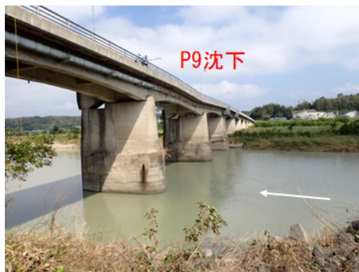
図-1 橋脚・桁沈下被災事例(球磨大橋 昭和32年竣工・ケーソン基礎 令和5年発生)
