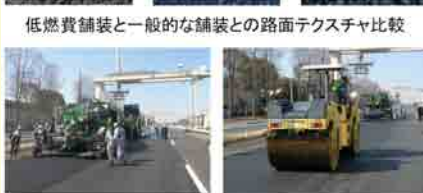
低燃費舗装の試験施工状況
