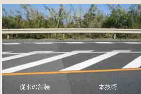
施工4年後の舗装状況
