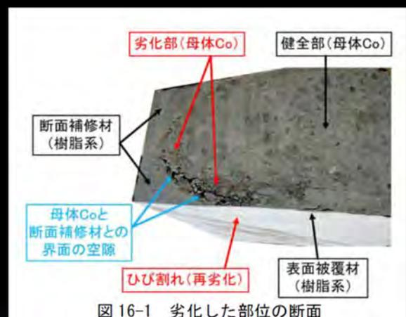
図 16-1 劣化した部位の断面
