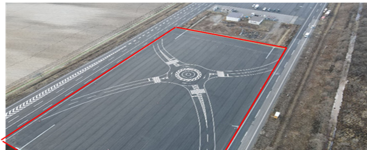
信号に依らない環状交差点実験施設新設
