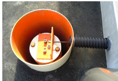
写真3 屋外の支持杭と鋼管
