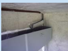
ポリエチレン製排水装置の遊間への挿入状況
