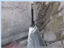
ゴム製排水装置の遊間への挿入状況
