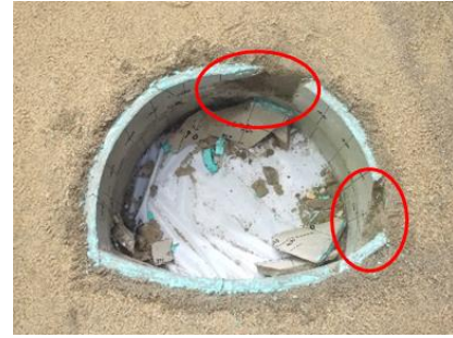
図-4 模型実験における覆工の破壊状況
