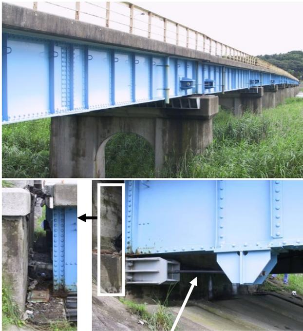
支承損傷により桁が
