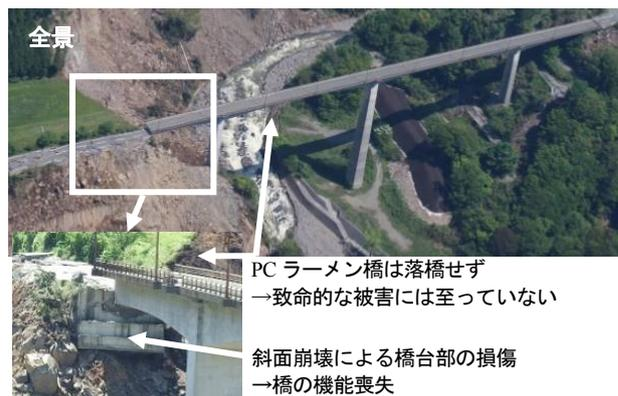
写真-7 阿蘇長陽大橋の損傷(熊本県)
