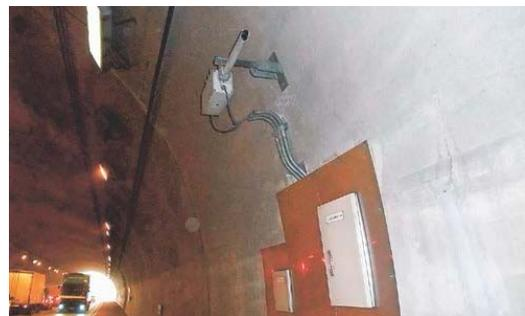
写真-1 煤煙透過率計の設置例
