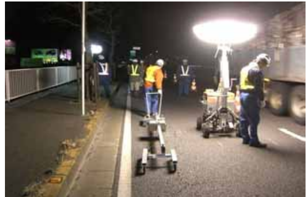
写真-1 プロファイラによる測定
