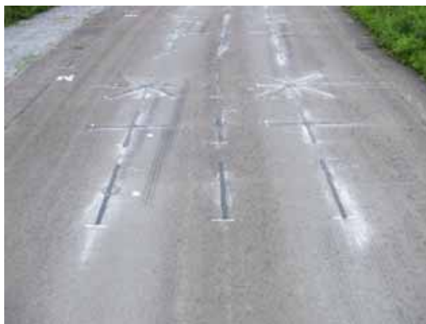
写真 - 1 シール材施工状況
