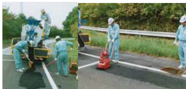
写真 - 14 加熱タイプ敷均し 写真 - 15 加熱タイプ締固め状況
