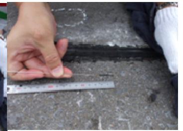
写真-6 シール材の浸透深さを測定している状況
