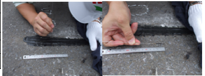
写真-5 シール材に鋼棒を突き刺している状況
