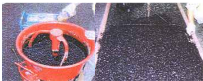
写真 - 16 常温タイプ混合状況 写真 - 17 常温タイプ敷均し状況
