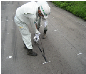
写真-3 人力施工(やかん)による注入状況
