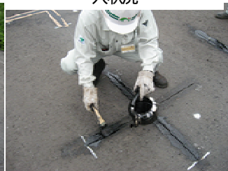
写真-4 刷毛施工による注入状況
