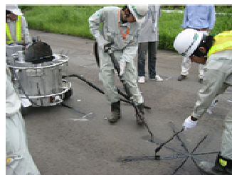
写真-2 機械施工による注入状況
