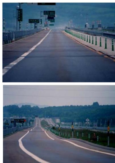
写真1 供用4年目の路面沈下(上:粘土地盤、下:泥炭地盤)
