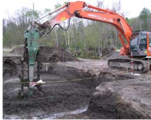
写真 2 トレンチャー式混合処理工法
