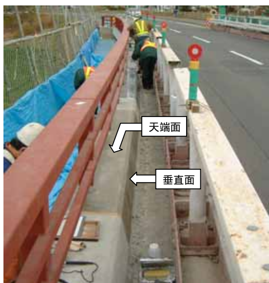
写真-3.1 試験施工状況 (A 橋)
