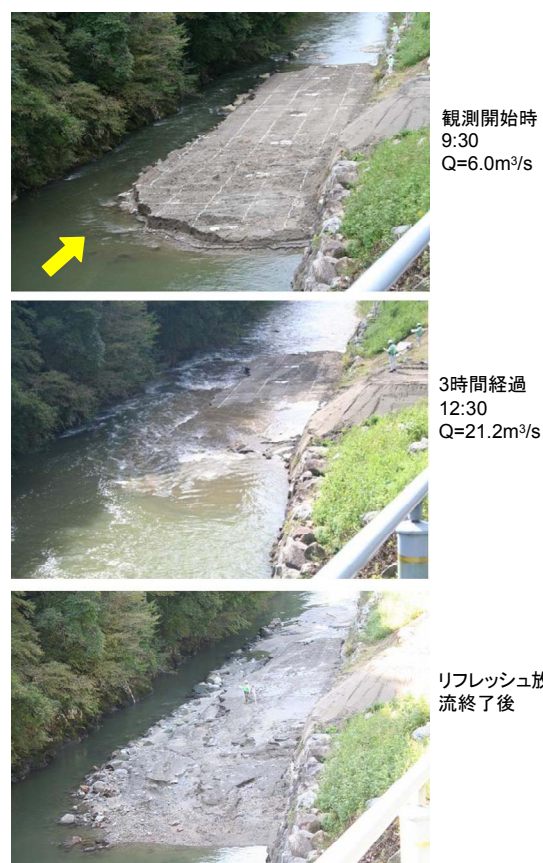
図-2.4 置土の侵食状況
