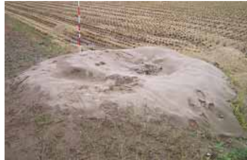
写真－1 直径 3m 程度の噴砂跡（左岸 15.5km 付近）
