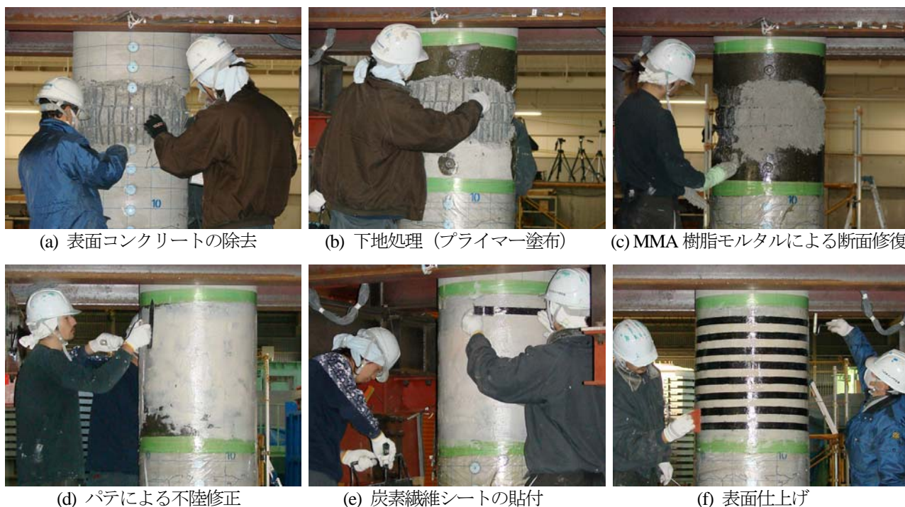
図-10 曲げ破壊した段落し部の速乾性の材料を用いた炭素繊維シートによる修復
