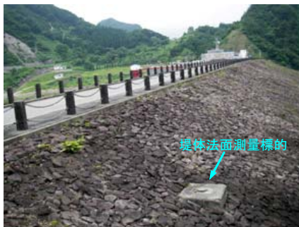
写真-3 フィルダム堤体下流側の可動標的
