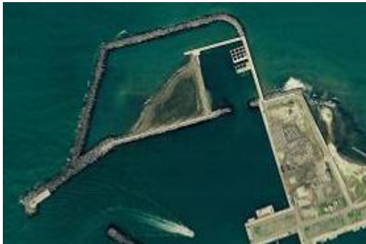
写真-5.1 抜海漁港蓄養水面
