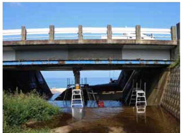
写真-1 各種塩害対策被覆を適用した調査対象橋梁 (橋の向こう側は海岸線)
