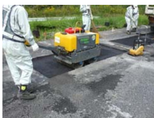
写真-15 基層転圧 (A工区)
