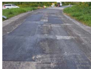
写真-20 施工完了
