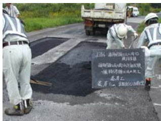
写真-19 表層舗設 (C工区)
