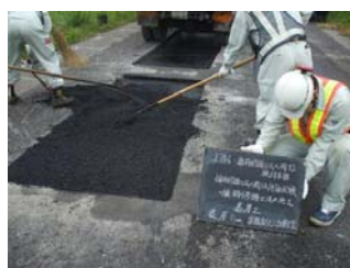
写真-16 表層舗設 (A工区)
