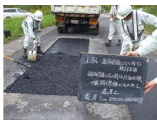
写真-18 表層舗設 (B工区)
