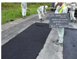
写真-17 基層舗設 (B工区)
