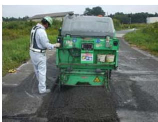
写真-13 既設舗装切削
