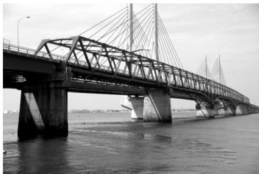
図-19 撤去予定の鋼トラス橋（手前）と新橋（奥）
