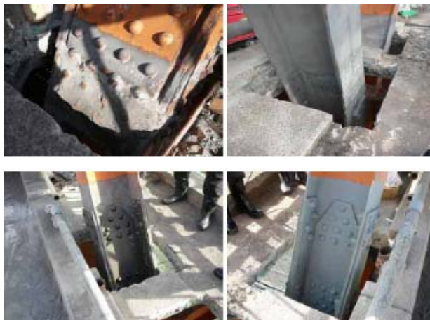
写真-2 床版埋め込み部材(減肉)に対するあて板補強
