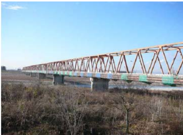
写真-1 A橋全景
