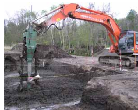
写真 2 トレンチャー式混合処理工法
