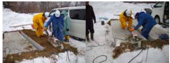
写真8 牽引力調査試験状況
