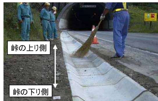
写真 - 2.1 皿形側溝の試験施工状況 (7 合目付近)
