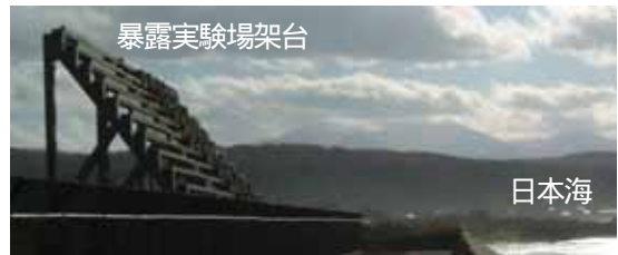
写真-3.1 増毛暴露実験場の全景
