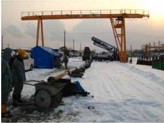
写真 - 4.3 ポンプ圧送試験の状況
