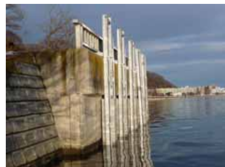
写真 - 2.2 護岸製品暴露試験状況
