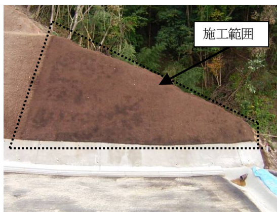
写真-3. 施工完了時の状況
