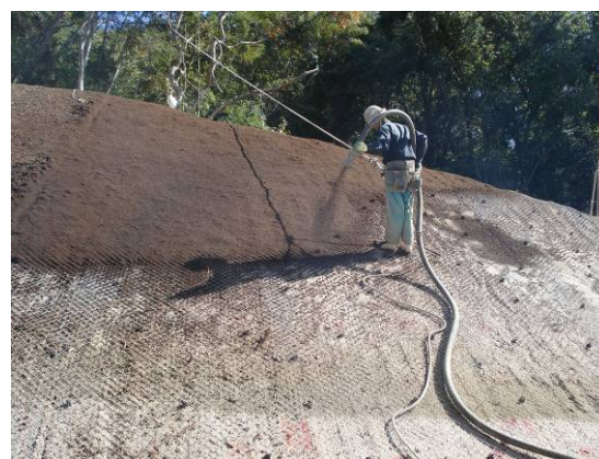
写真-2. 施工時の状況
