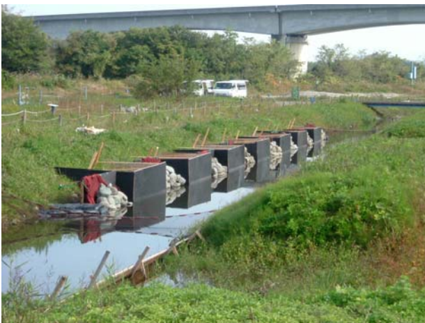
写真 1 調査区 凹部に礫群を設置
