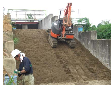
写真-2 堤防裏のり面被覆の転圧状況
