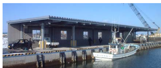
写 1-1 漁港における防風雪施設の例
