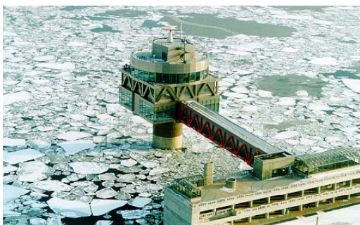
図-5.4(c) 水面付近のコンクリート表面をチタンクラッド鋼で保護 (オホーツクタワー)
