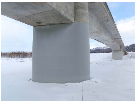
図-5.4(b) 鋼板が取り付けられた橋脚 (天塩川)
