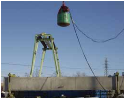
写真 - 1-1 重錘落下衝撃実験状況 ( W_m = 5t, H = 4m )
