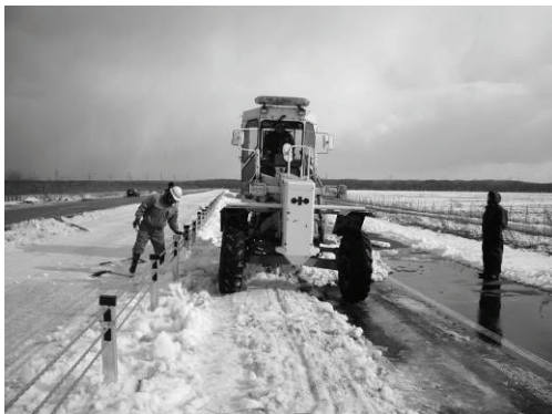
図 24 除雪作業に伴う支柱への影響の確認
