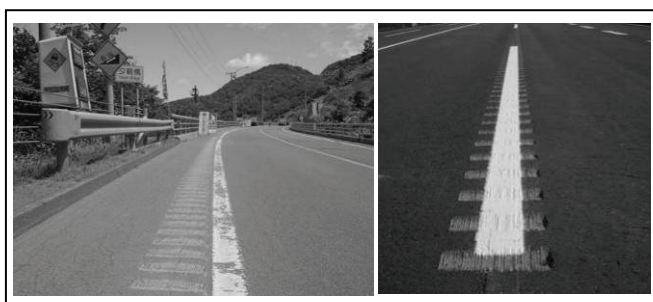
図12 多様化するランブルストリップ (左:路肩用、右:白線破線区間用)
