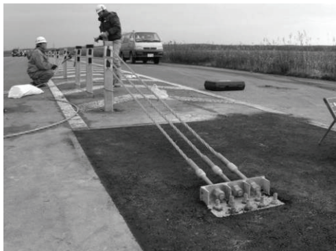
図 23 苫小牧寒地試験道路での試験施工
