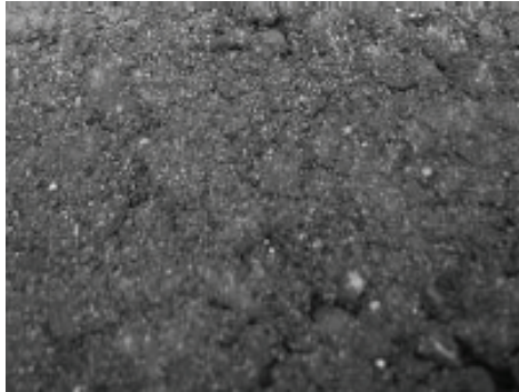
図16 アスファルト表面
