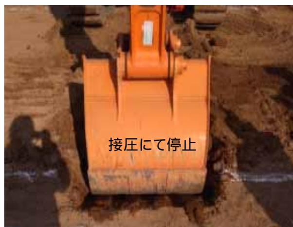
写真-7 バケット底部に発生した接圧によって停止
