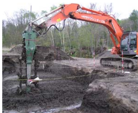
写真2 トレンチャー式混合処理工法
