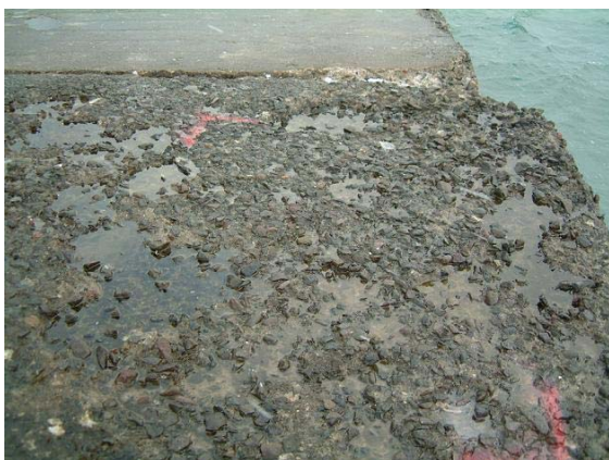
写真-4.1 剥離度 31mm の天端面
