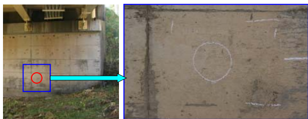
写真-3.10 A橋橋台堅壁前面部分(健全部)
