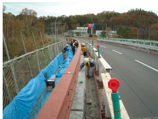
写真-3.4 地覆試験施工(美幌橋)
