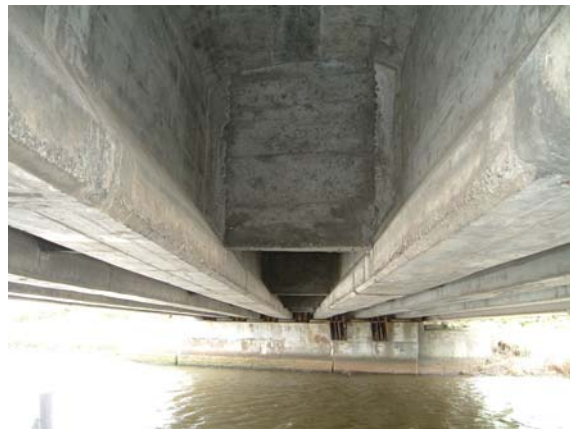
写真-3.2 主桁の状態
