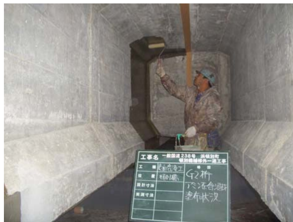
写真-3.3 施工状況 (G2、含浸性防錆材の塗布)
