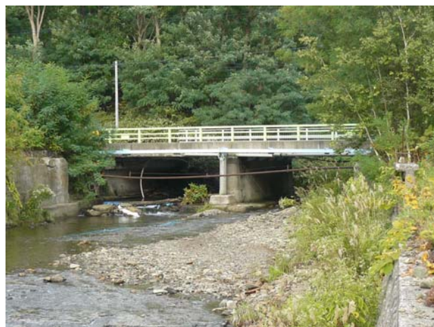
写真-4.1 対象構造物の外観
