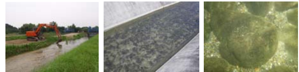
写真-1 砂投入の状況と砂の掃流状態
