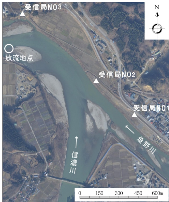
図-3.2 ATS 受信局設置状況
