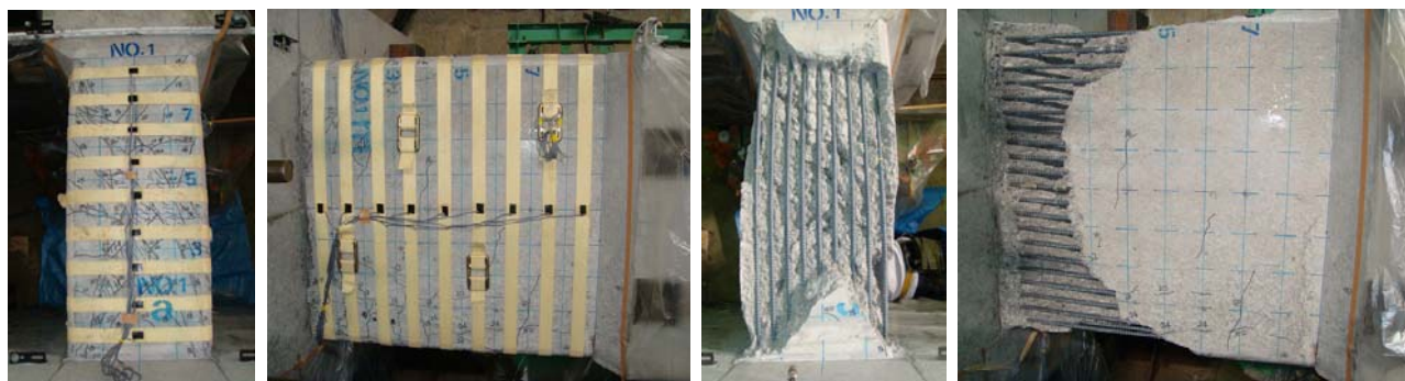
(a) 荷終了後 (b) 損傷コンクリート除去後 (1) No.1 模型 (初期緊張力あり)
