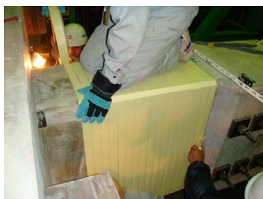
(d) 繊維バンドの巻き立て（スパイラル巻き）
