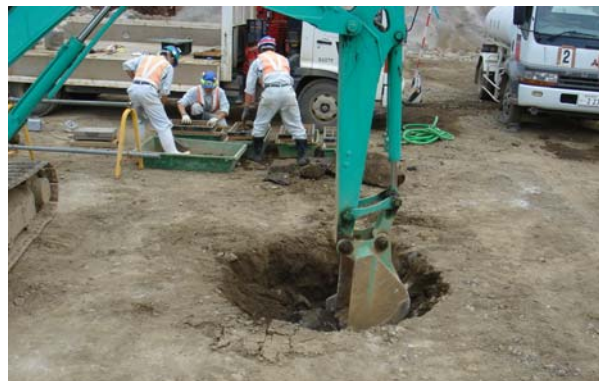
写真-3 ロックの原位置密度試験の状況
