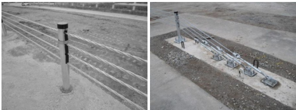
図15 試作品(左:中間支柱、右:端末)
