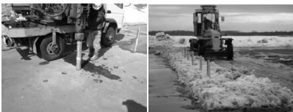
図16 試験施工と除雪作業に伴う支柱への影響の確認
