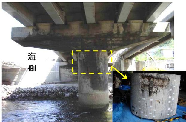
写真-1 撤去直前の橋脚の損傷状況と撤去後のブロック
