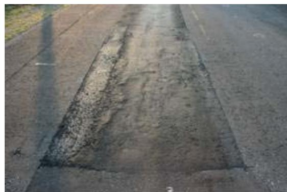
写真-11 N 工区 (施工後夏季の 12 日間に約 4 万輪走行後)
