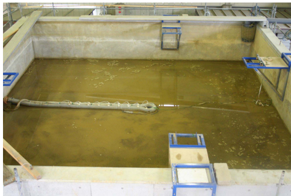
(排砂管の設置状況、給水前)
