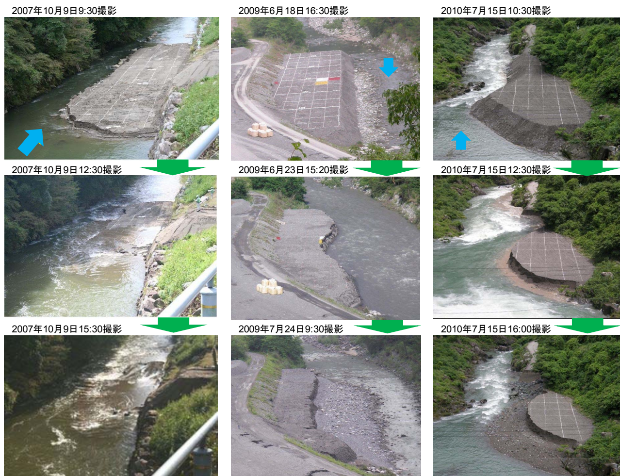
図-2.7 現地観測の置土侵食状況
